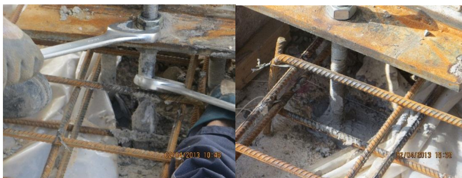
FIGURE 18. Actual Pedestal Casting
